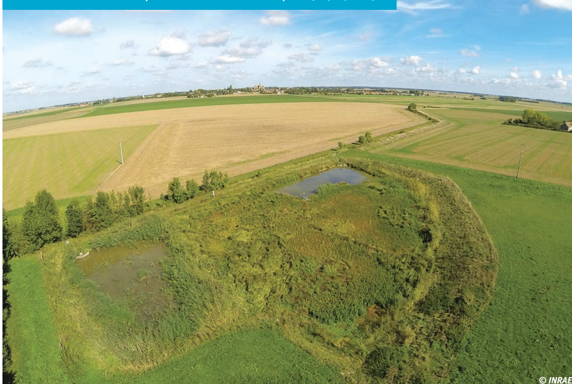
1 Vue aérienne de la zone tampon humide artificielle de Rampillon ( 21/09/2015).
