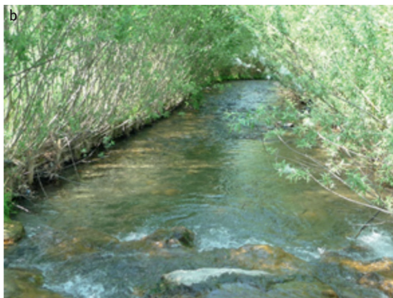
Figure 3 – Fascine de pied de berge sur le Vorz (a) à l'installation en 2007 et (b) après quatre saisons de végétation en 2011. Photo a : © Belleudy – Photo b : © André Evette.
