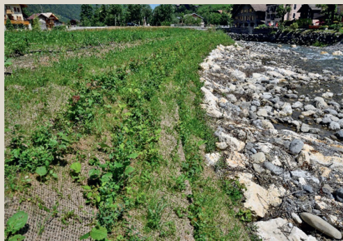
Figure 1 – Comparaison des méthodes ancestrales de lutte contre l'érosion et des techniques modernes : à gauche, iconographie ancestrale de la construction d'ouvrages à base de fascines et tressage pour la navigation, Cornelius Meyer (1685) ; à droite, ouvrage moderne de génie végétal constitué de lits de plants et plançons associés à un pied de berge enroché (source : © Sébastien De Danieli).
